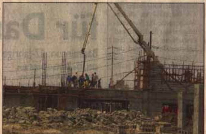
Die Baustelle im philippinischen Manila: Hier soll ein komplettes Schulzentrum entstehen.
